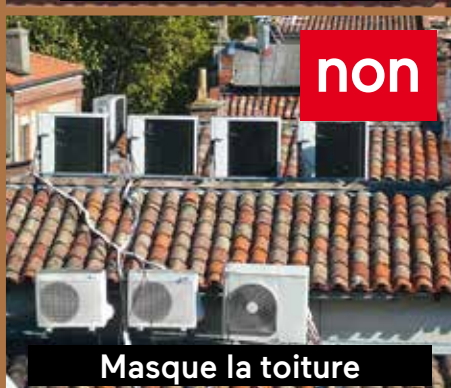
Ventelle sur toiture mal intégrée
